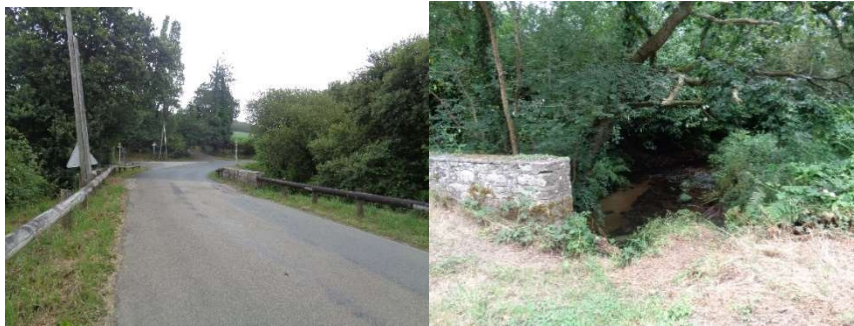
Figure 18 : Photos : Pont de Kerolier RD39 et route de Hent ar Veil
