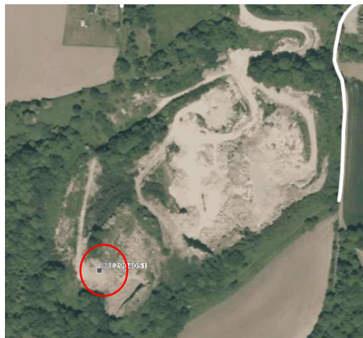
Figure 19 : Photo aérienne localisant l'ancienne décharges d'ordures ménagères
