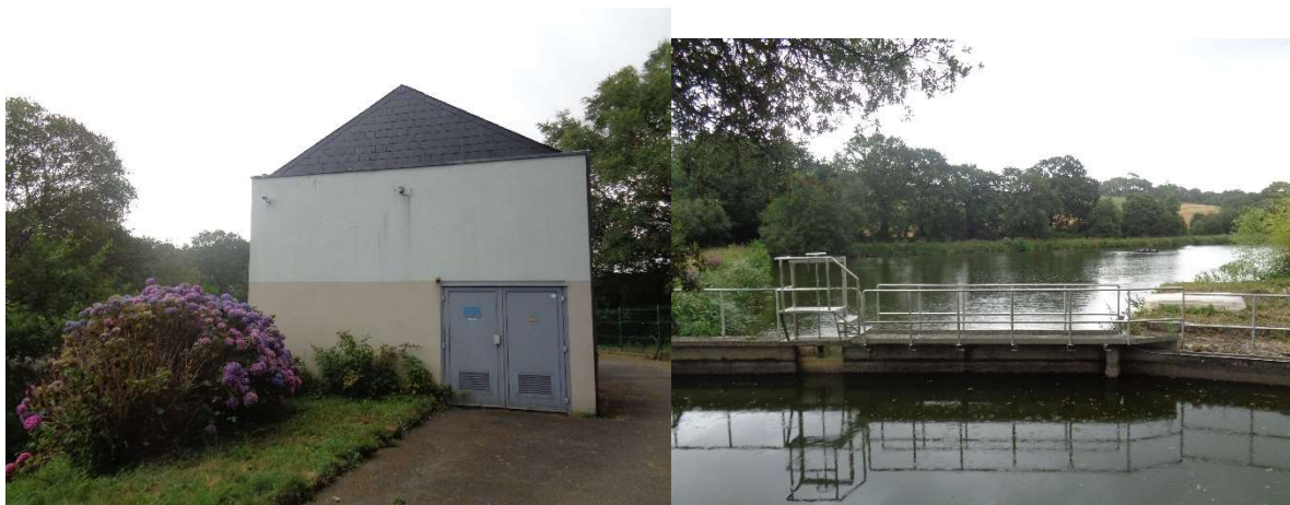
Figure 4 : photo station de pompage et barrage
